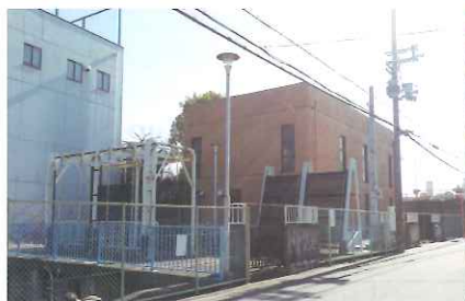
① 味生排水機場
