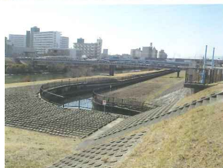
③江口樋より下流部
