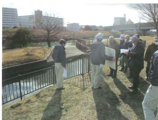
味生排水路転落防止柵設置工事
