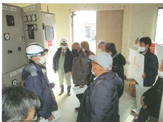
三箇牧揚水機場高圧機器取替工事
