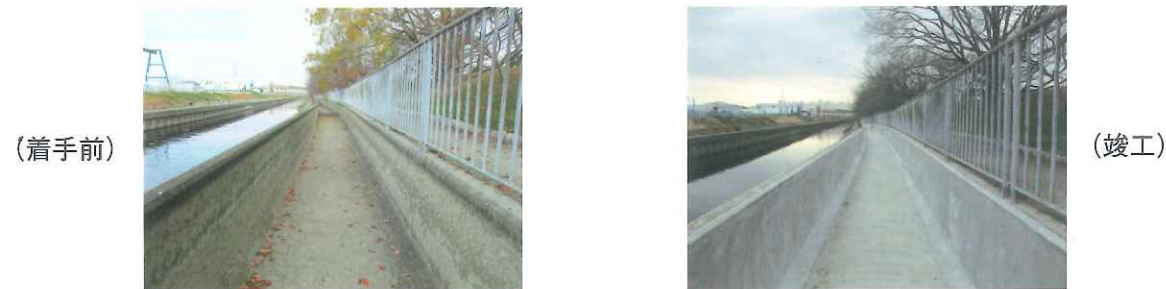
【玉川用水路補修工事(第1工区)】
