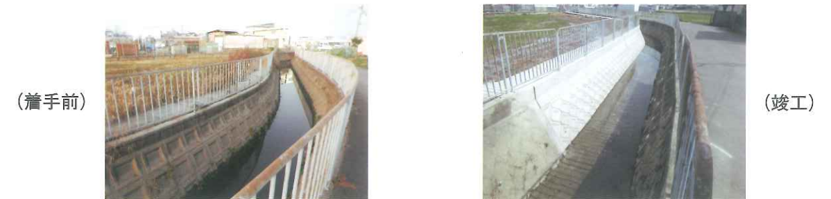
【三島江柱本水路整備(31-2)工事】
