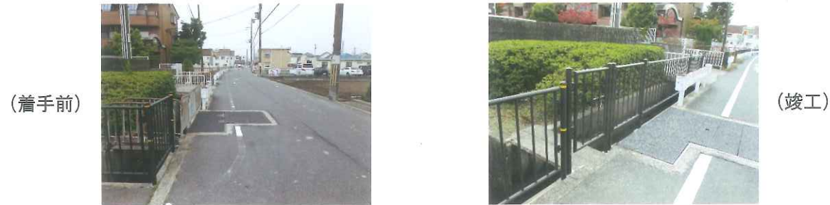
【神安地区水路転落防止柵設置工事(墓路・鮎川・別府東水路) 鮎川水路】
