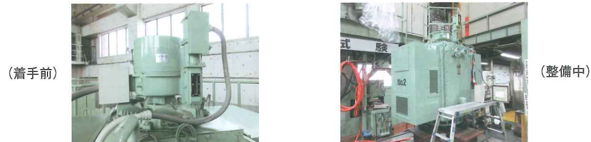
【三箇牧揚水機場2号揚水ポンプ主電動機整備工事】
