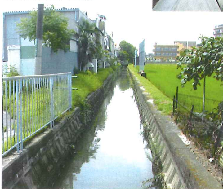
改修前の唐崎水路 (上流部)
