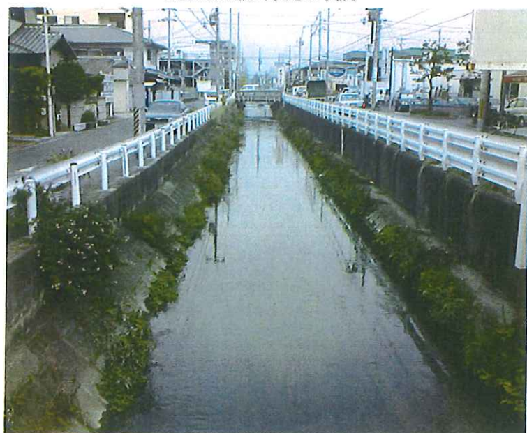
現在の高瀬川水路の状況
