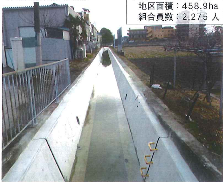
改修後の唐崎水路 (上流部)
