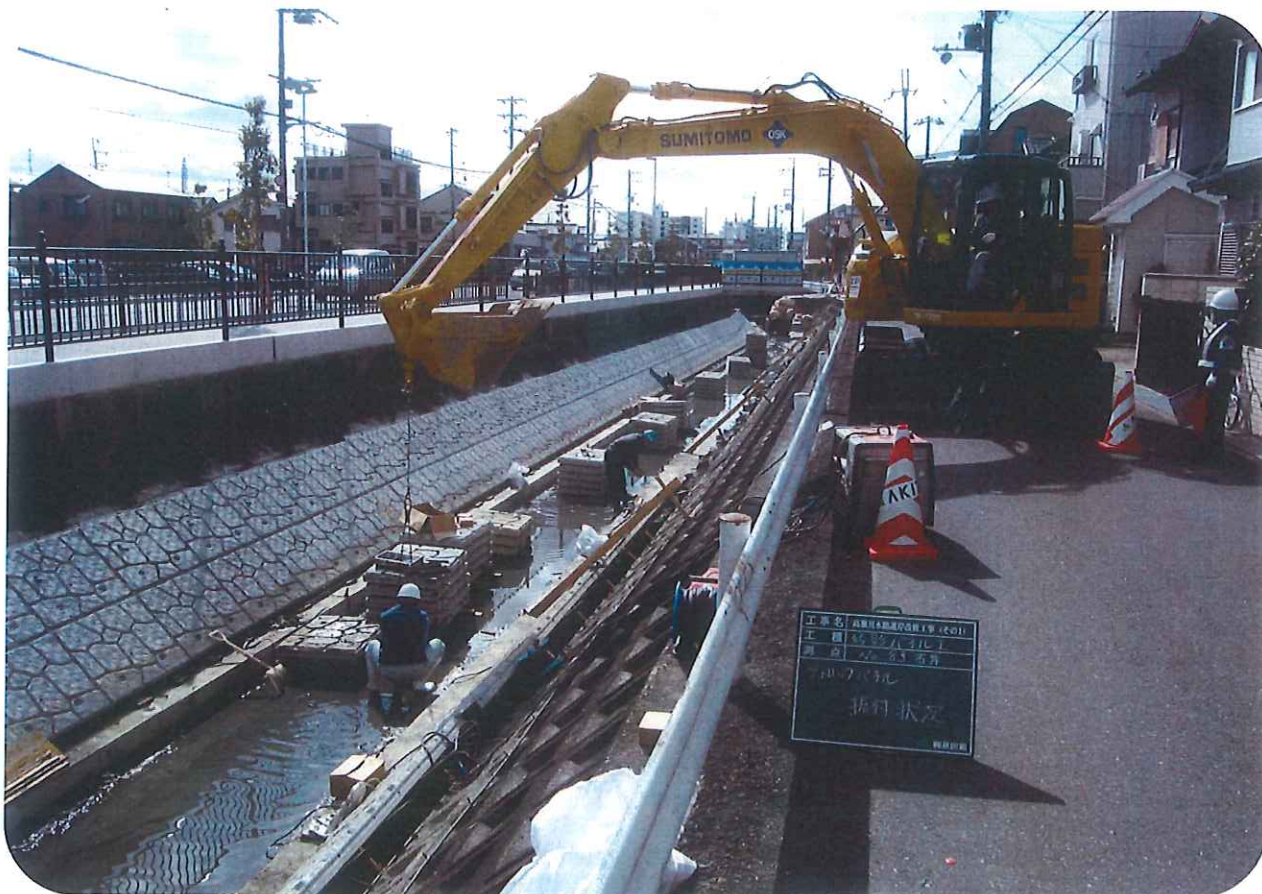
本年度より本格的に始まった高瀬川水路の改修工事
