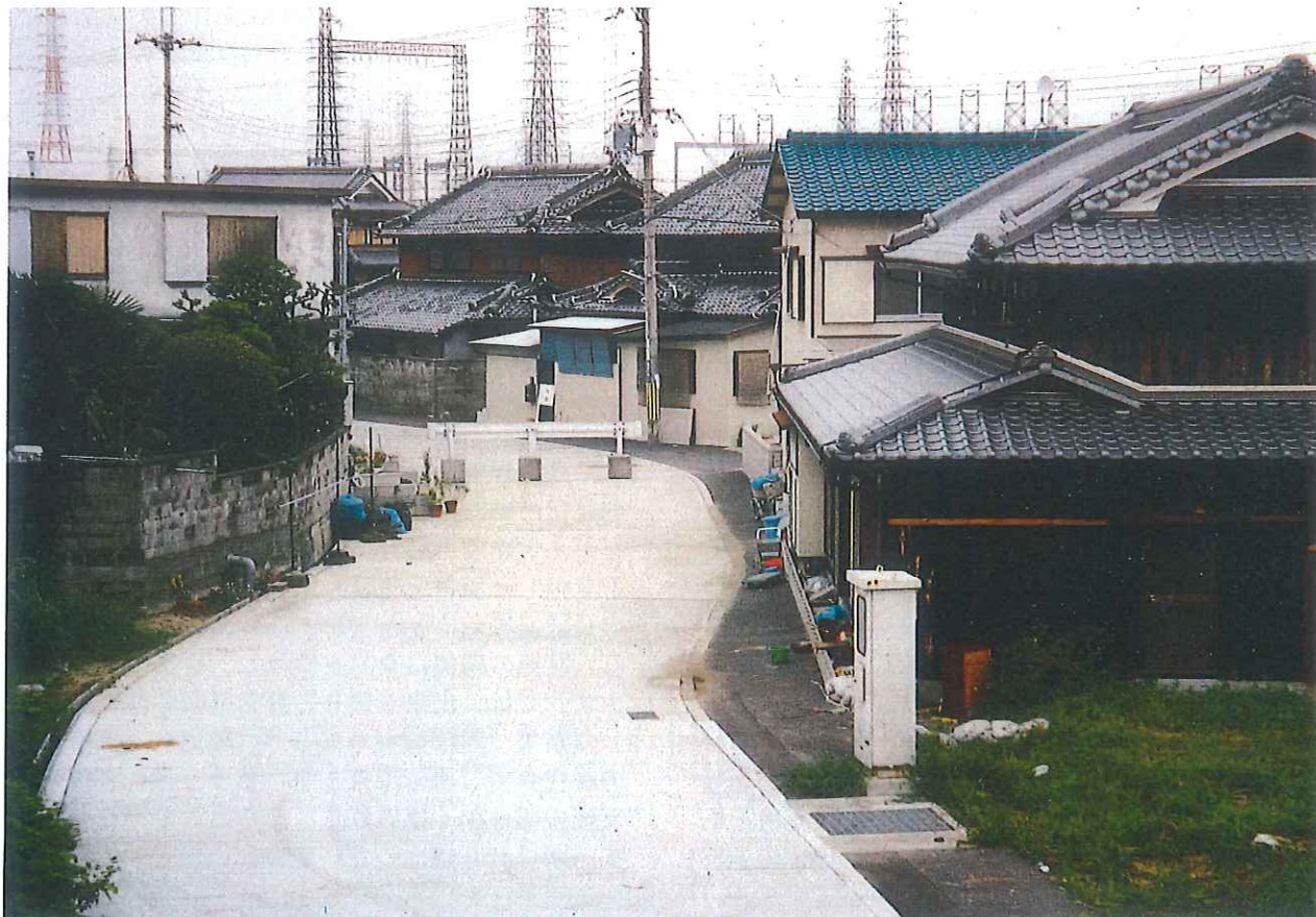
府営地盤沈下対策事業及び公庫融資事業により鳥飼八町集落の中 L=680mの蓋掛けが完成
