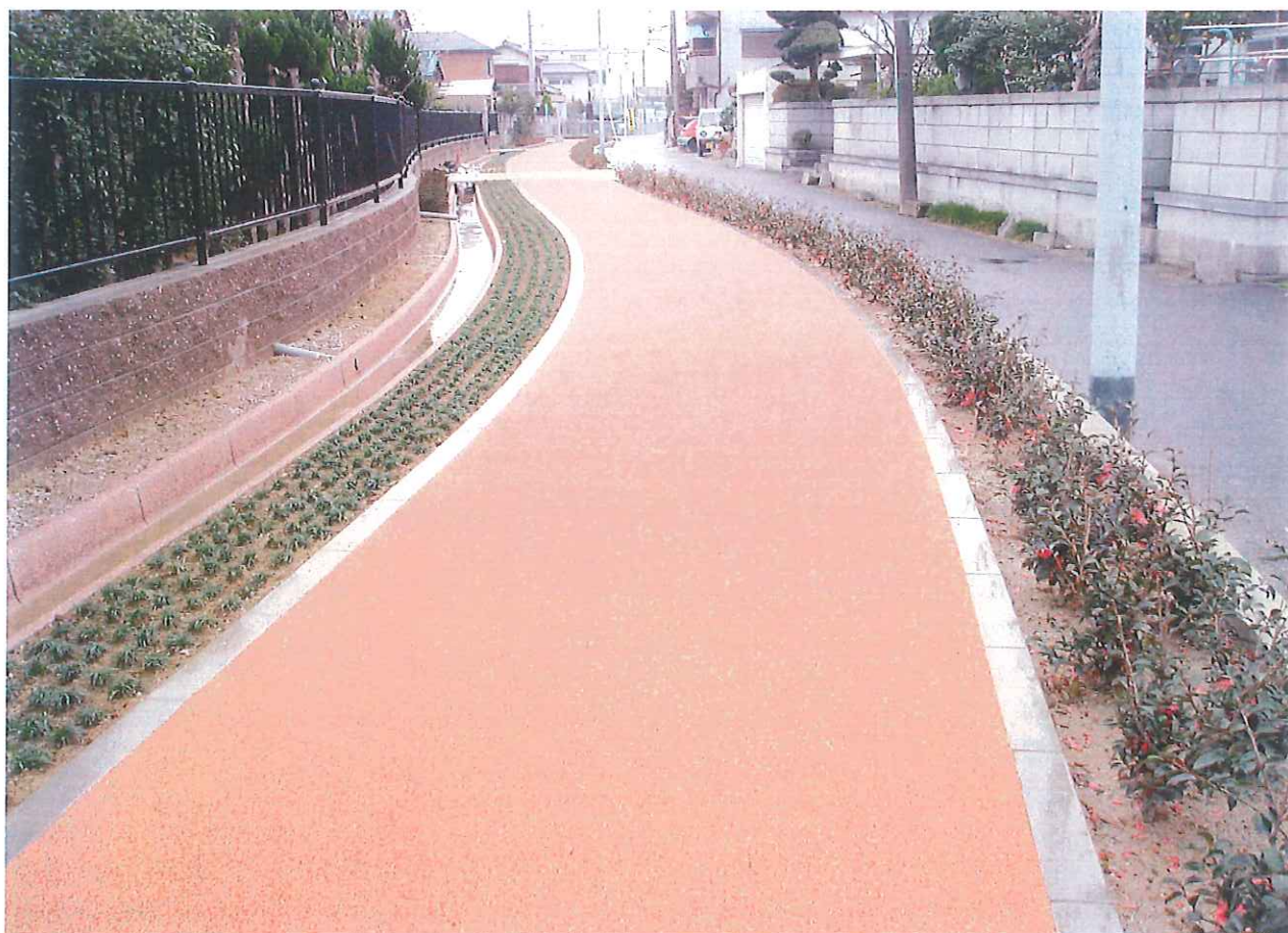
完成なった三箇牧水路（中橋より下流を望む）
