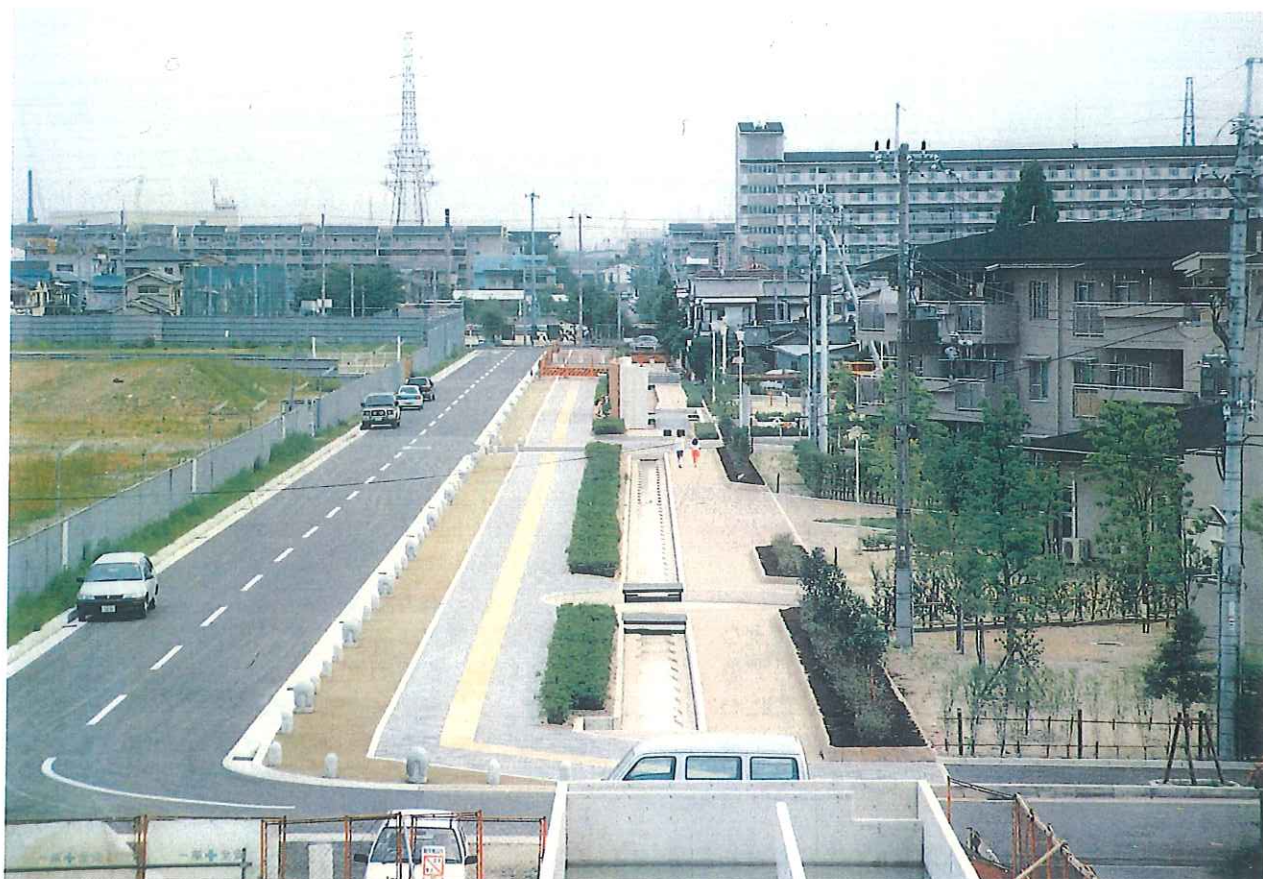
いきいき水路モデル事業により一部完成した津之江水路
