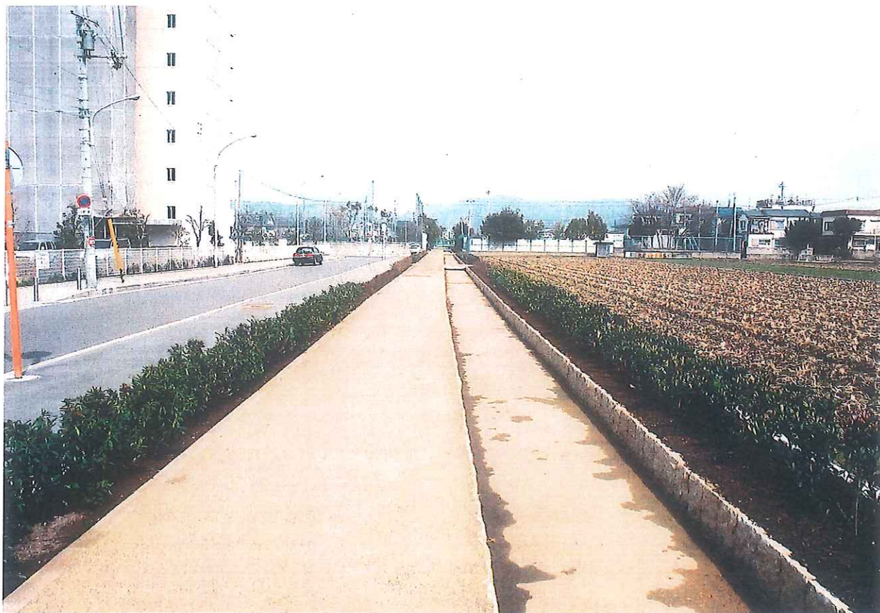
完成なった津之江水路（芝生町2丁目地内）
