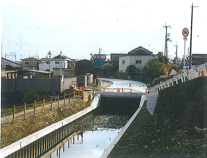
府営地盤沈下対策事業及び公庫融資事業により鳥飼八町集落の中 L=680mの蓋掛けが完成
