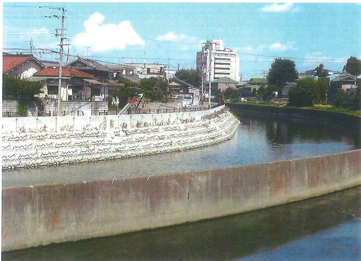
平成 18 年度をもって完了した番田下流部の護岸嵩上げ工事（摂津市浜町）
