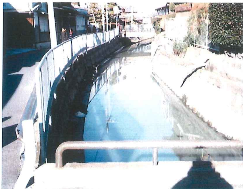
着工前（下流より中橋を望む）
