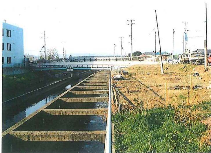
幹線用水路「番田地区」現況（西面大橋付近）
