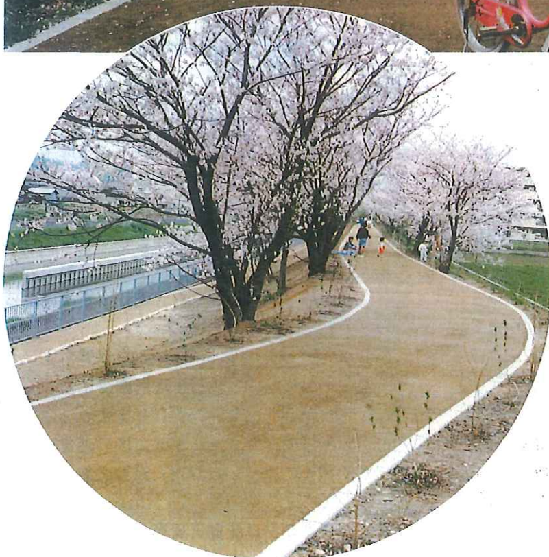
番田堤防アメニティ工事で完成した 玉川桜通り
