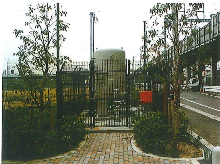
鳥飼北部地区ポンプ場
