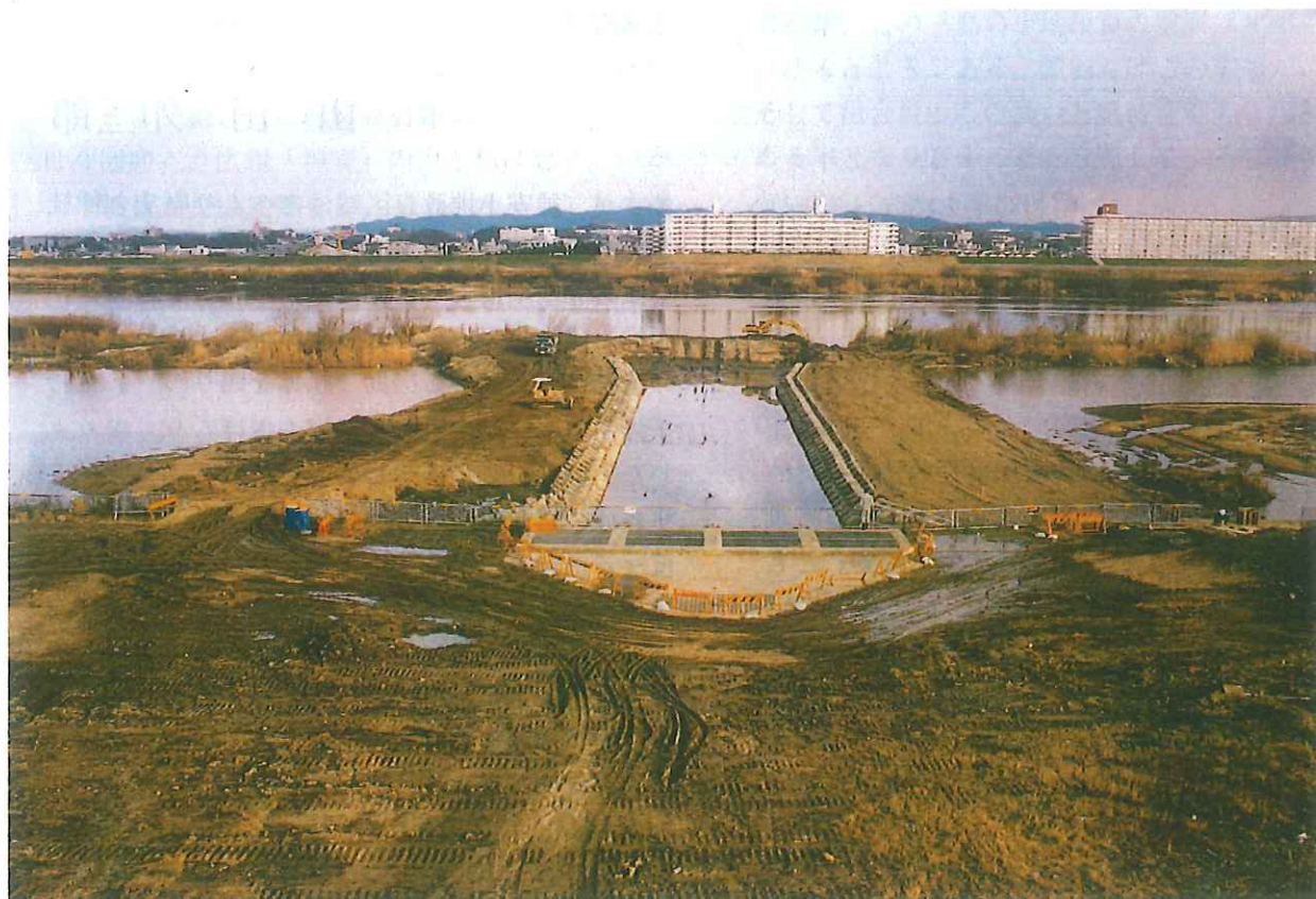
安定した用水確保のため建設省により実施された、三ヶ牧揚水 機場取水口を淀川本流まで延伸する仮導水路新設工事
