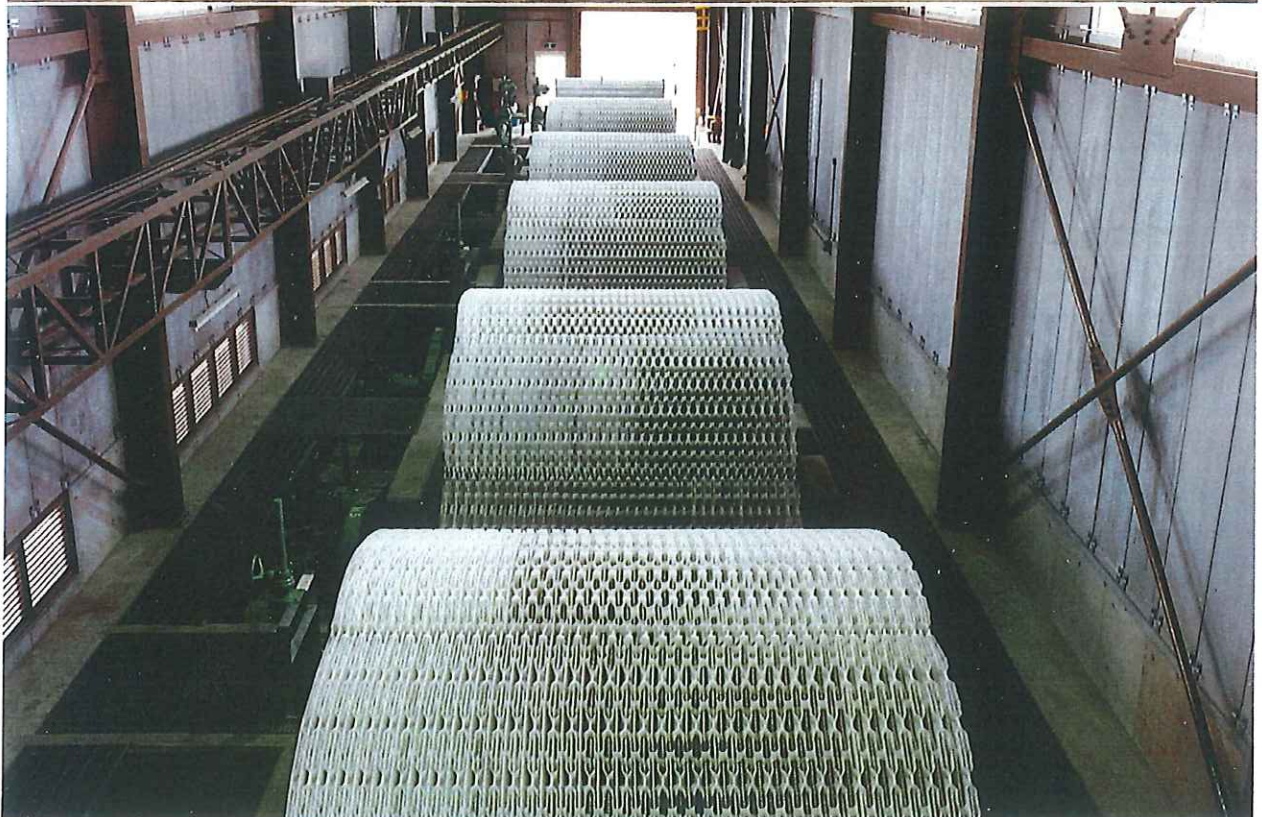
玉島浄水機場（茨木市野々宮1丁目地先）
