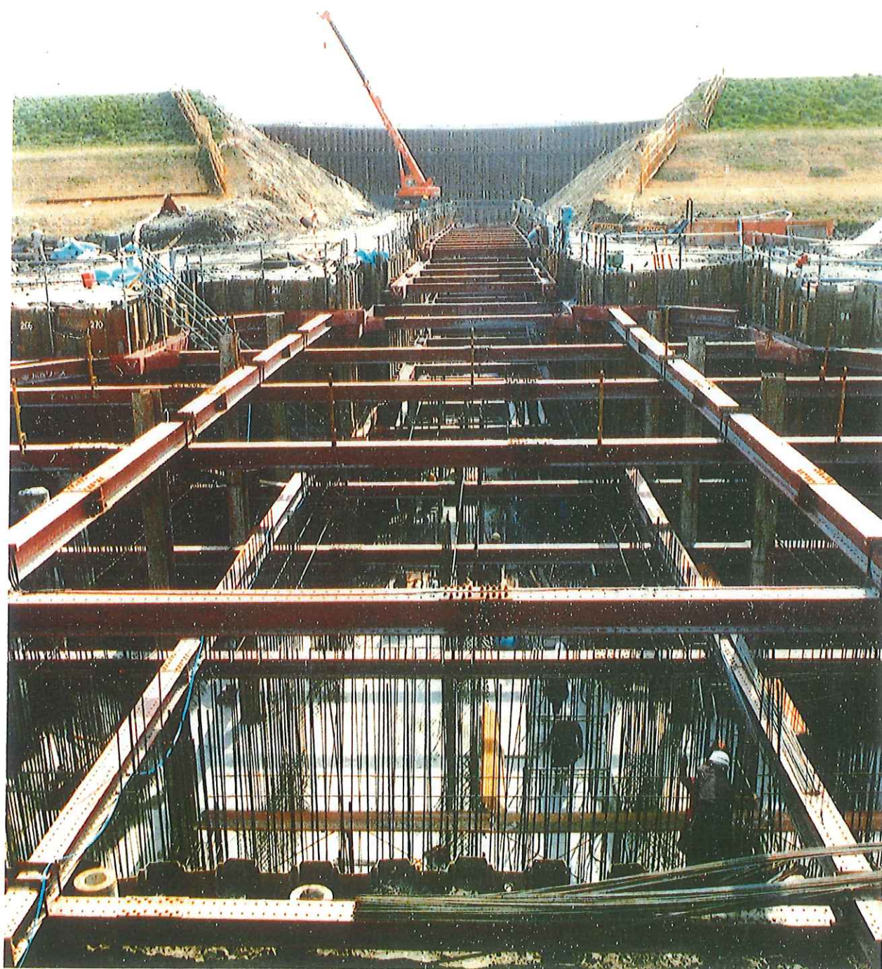
三ヶ牧ポンプ場導水路工事
