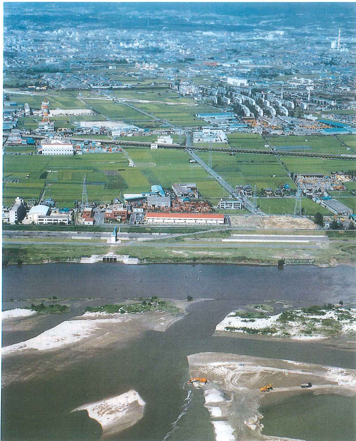
淀川上空より本土地改良区三箇牧揚水機場・浄水場周辺を望む
