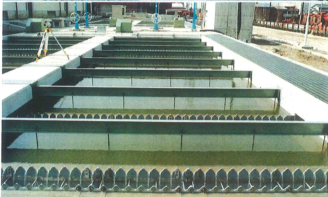
試運転を始めた円板体と沈澱槽（三ヶ牧浄水機場）
