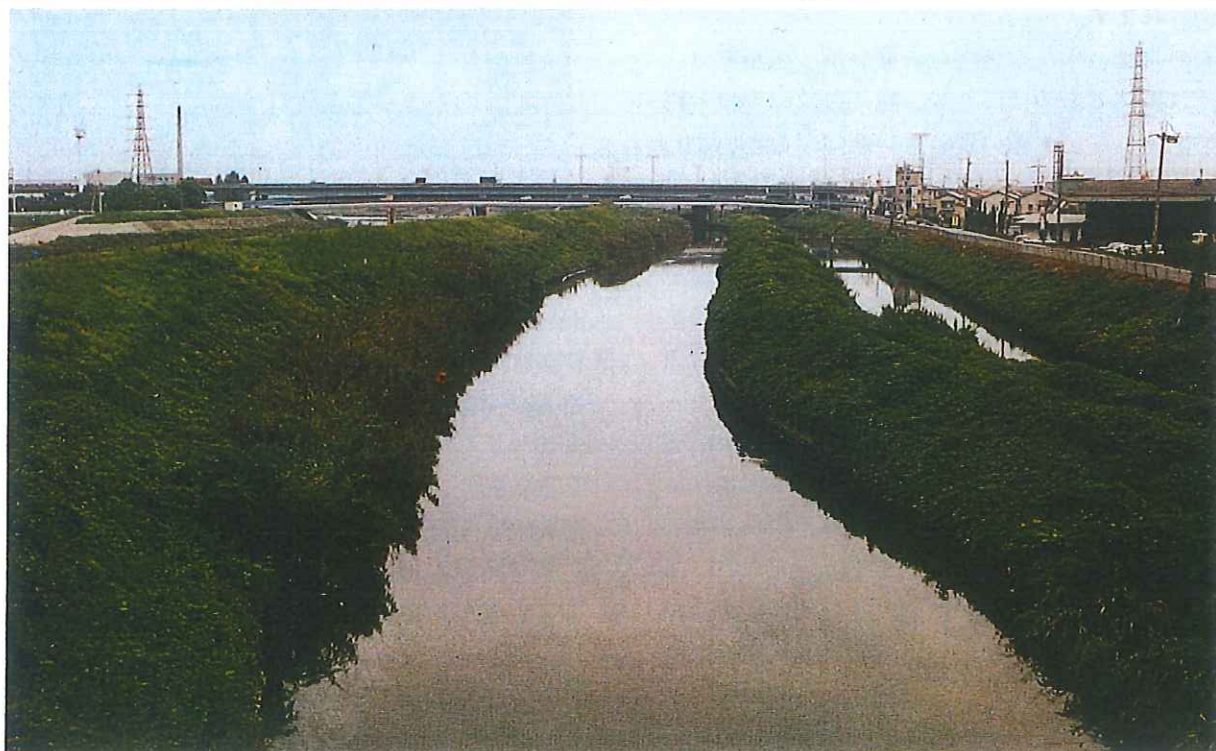
番田排水路第1—5工区整備工事（摂津市北別府町地先）
