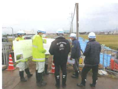
西面北水路改修工事(第1工区)
