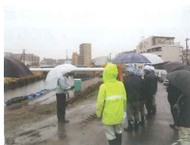
幹線排水路整備(5)工事(その2)
