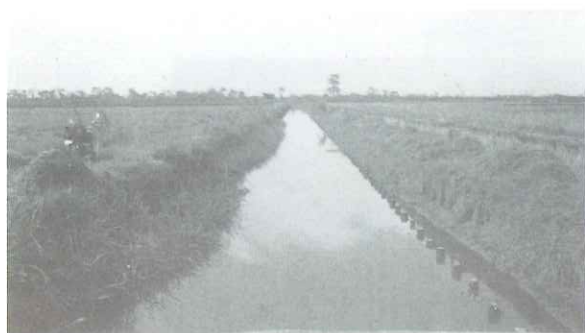
【新たに開削された当時の幹線用水路】
