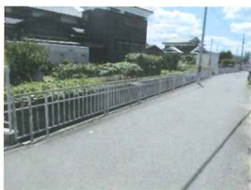
図4 三島江柱本水路
