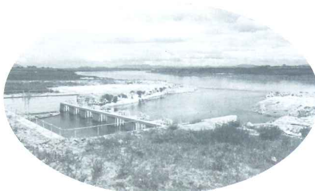
【淀川に設置された取水口】
