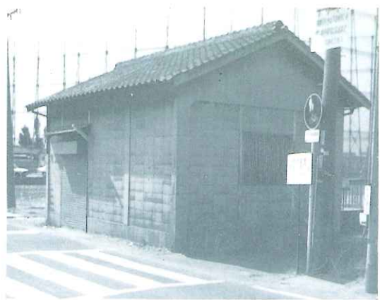
【玉島地区へ送水する二階堂揚水機場】
