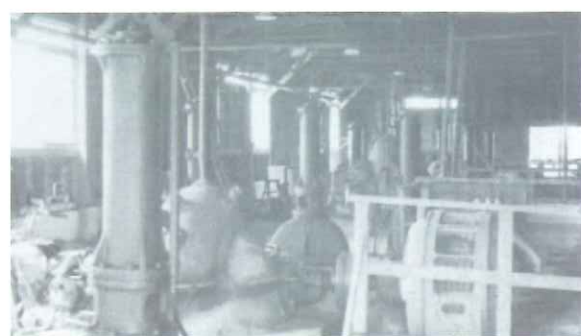
【当時の三箇牧揚水機場内部】
