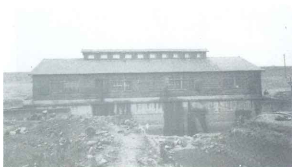
【当時の三箇牧揚水機場外観】
