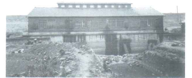
三箇牧揚水機場外観
