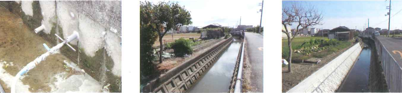
グラウト注入
