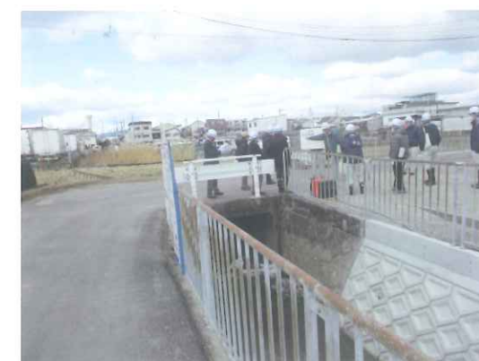
大阪府営事業 三島江柱本水路整備(3)工事(その2)
